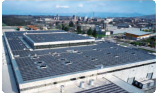
Neue Messe, 440 kWp, Freiburg i.Br.
